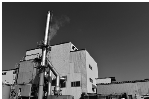
産業廃棄物処理用の焼却炉
